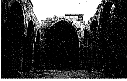
Amasya Dârüşşifası'nın içinden bir görünüş
